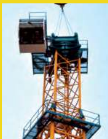
MONTAGGIO GRUPPO ROTANTE SLEWING GROUP ASSEMBLY
