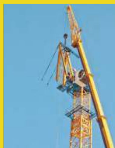
ASSEMBLAGGIO CUSPIDE ASSEMBLY SPIRE
