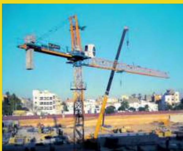
ASSEMBLAGGIO BRACCIO JIB ASSEMBLY
