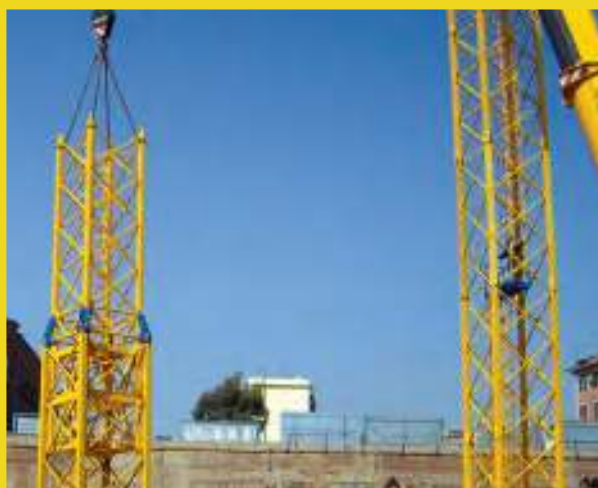
POSIZIONAMENTO DELL'ELEMENTO TELESCOPICO TELESCOPIC FRAME ASSEMBLY
