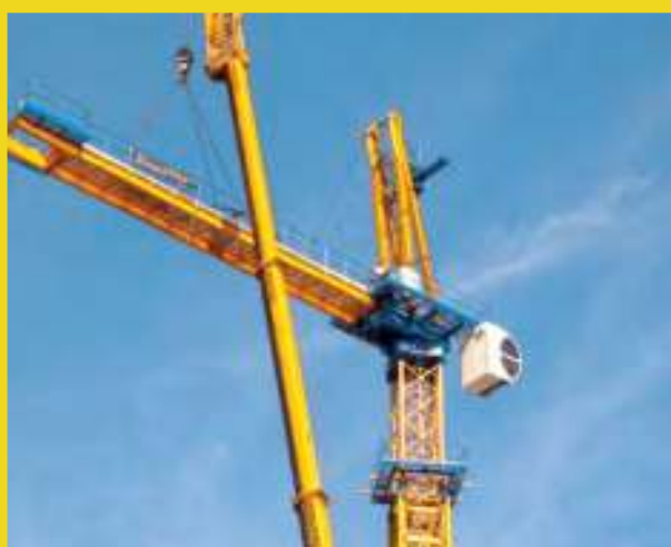
ASSEMBLAGGIO CONTROFRECCIA COUNTER JIB ASSEMBLY
