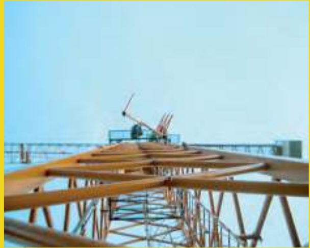
ASSEMBLAGGIO SEMIELEMENTI DI TORRE DURANTE TELESCOPAGGIO ASSEMBLY OF TOWER ELEMENTS DURING CLIMBING
